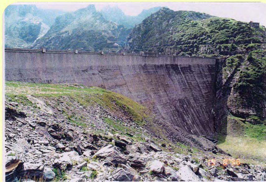
4.1 Paramento di valle
